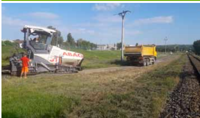
Oprava komunikace podél Trkmanky u čistírny odpadních vod.
