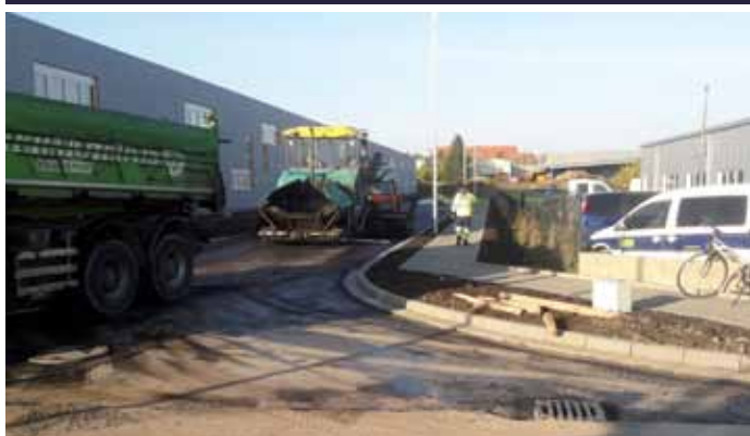
Výstavba infrastruktury v průmyslové zóně – směr Bořetice
