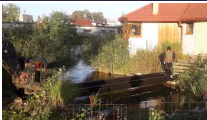
Výměna mostku nad tůní u rybářské bažty na ulici Nádražní
