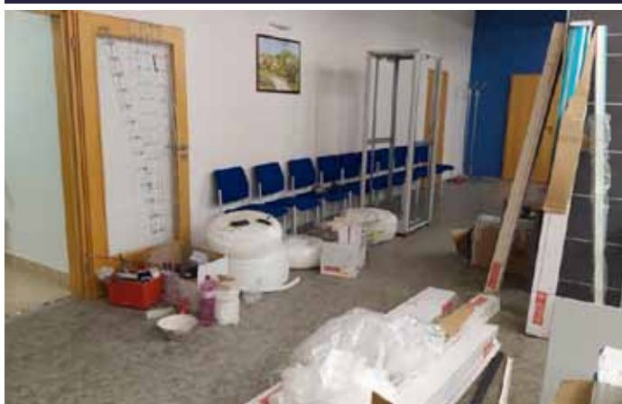
Rekonstrukce slaboproudých rozvodů na radnici města
