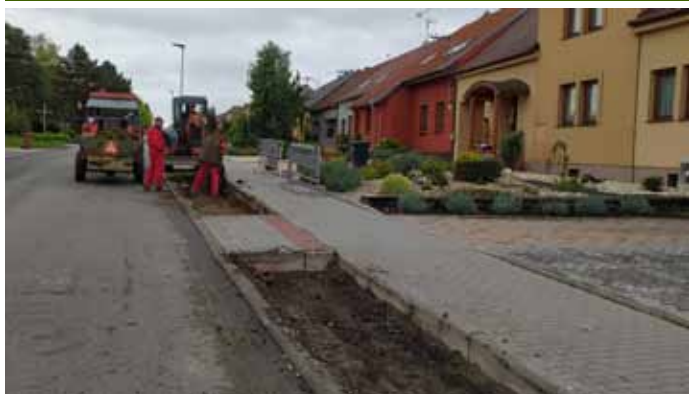
Ulice Dlouhá – budování podélných parkovacích míst
