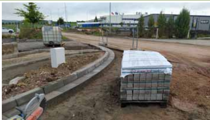
Průmyslová zóna – výstavba komunikace
