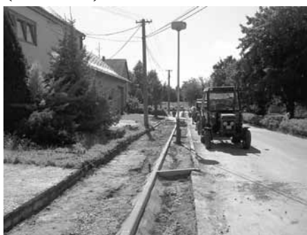
Oprava chodníku na ulici Herbenova.
