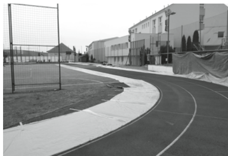
Oprava běžecké dráhy na stadionu za budovami gymnázia a základní školy.
