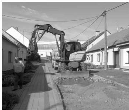
Oprava vozovky v horní části ulice Střední.
