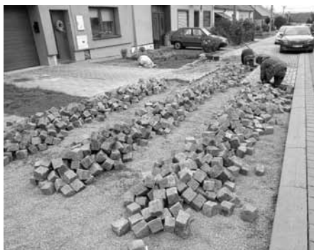
Pokládka žulových dlažebních kostek v horní části ulice Střední.
