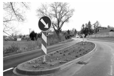
Zpomalovací ostrůvek při vjezdu do města od Němčiček – bezpečnostní a zároveň estetický prvek.
