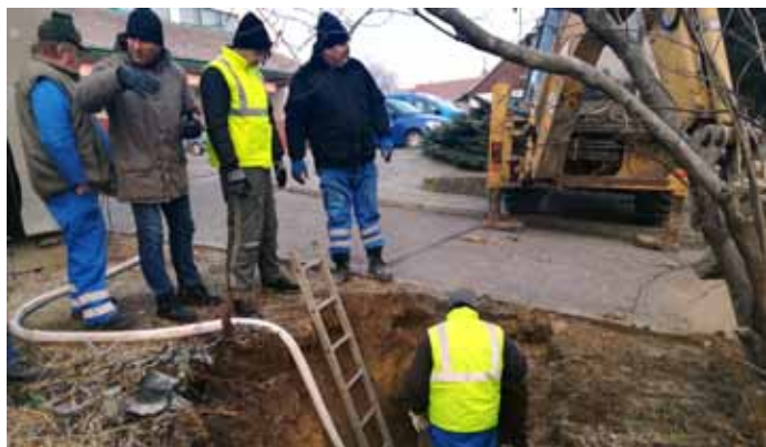
Oprava vodovodního řádu na ulici Hlavní
