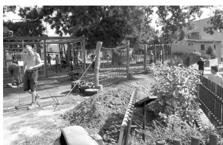
Oprava a výměna herních prvků na dětském hřišti za kostelem.
