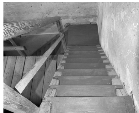
Nově opravené dřevěné schodiště ve věži velkopavlovického kostela.
