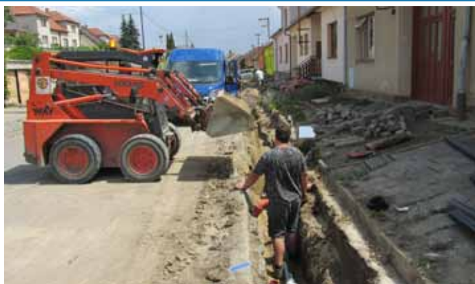
Výměna vodovodního řadu na ulici Zelnice
