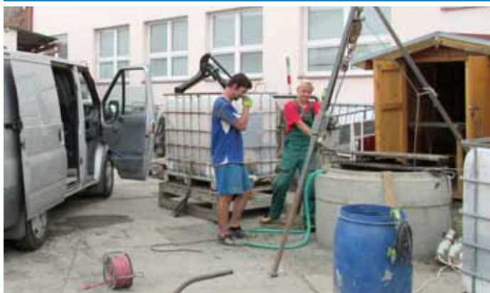
Čištění studny na dvoře za radnicí
