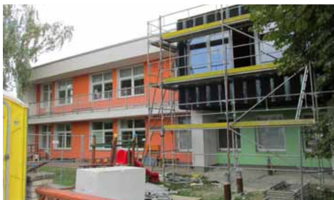
Práce na přístavbě nové třídy mateřské školy
