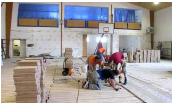
Rekonstrukce tělocvičny základní školy – výměna podlahy
