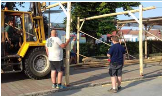
Stavba přístřešku na sóle za sokolovnou
