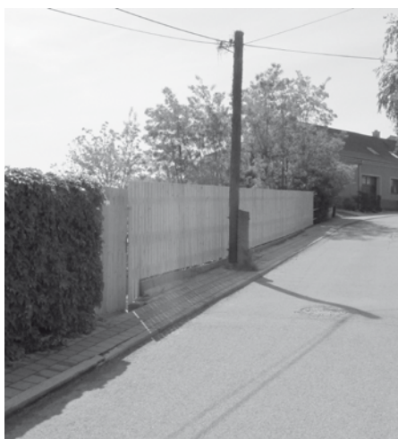
Nové dřevěné oplocení v ulici V Údolí.
