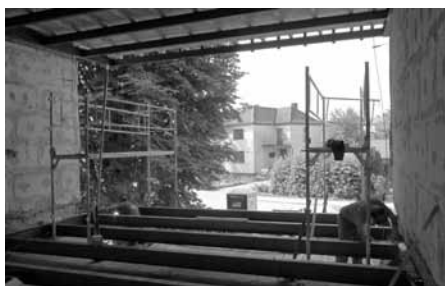
Práce na přístavbě nové třídy v budově mateřské školy.
