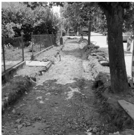
Chodník na ulici Hlavní během generální opravy.
