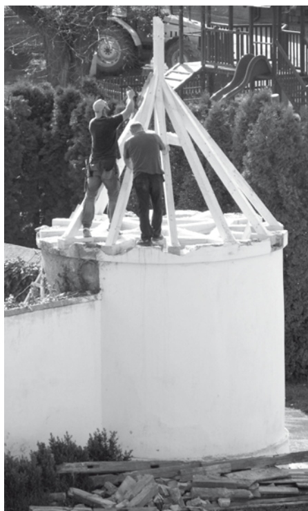
Nárožní kaple velkopavlovického hřbitova prochází výměnou krovů.
