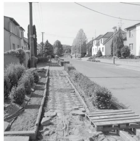
Zahájení opravy chodníku na ulici Růžová, demontáž starých nevyhovujících dlaždic.
