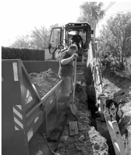
Výměna vodovodního řadu na ulici V Údolí.
