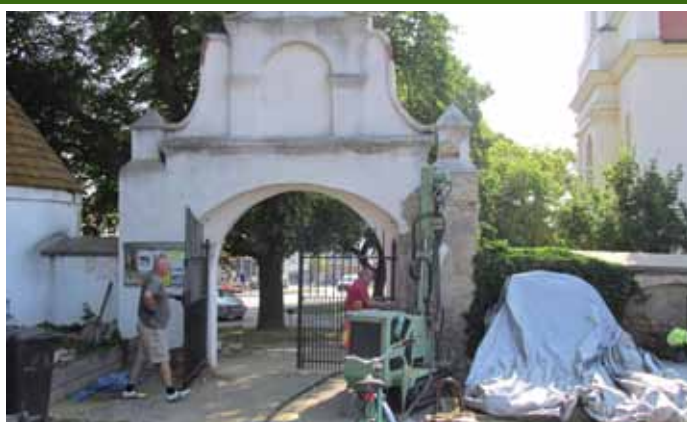
Oprava hřbitovní brány – statické zajištění
