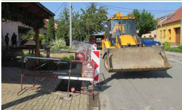
Výměna vodovodního řádu na ulici Ořechová
