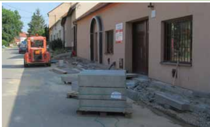
Zahájení II. etapy rekonstrukce chodníku na ulici Bezručova
