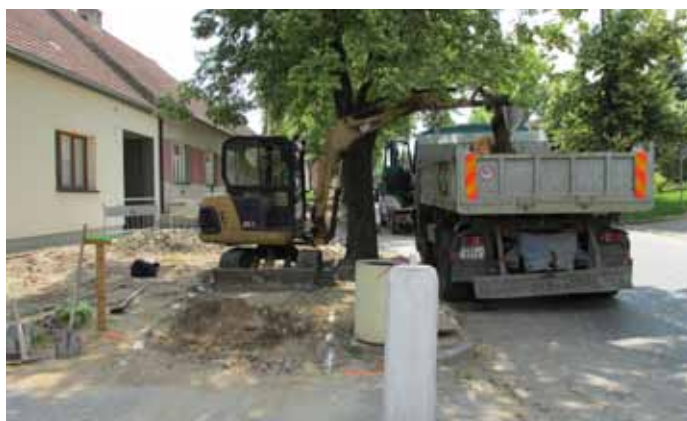
Zahájení prací na budování chodníku na ulici Hlavní
