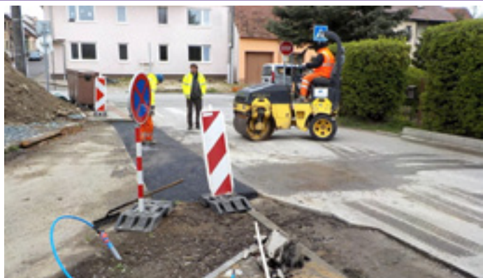
Pokládání nového asfaltového povrchu vozovky na ulici Pod Břehy
