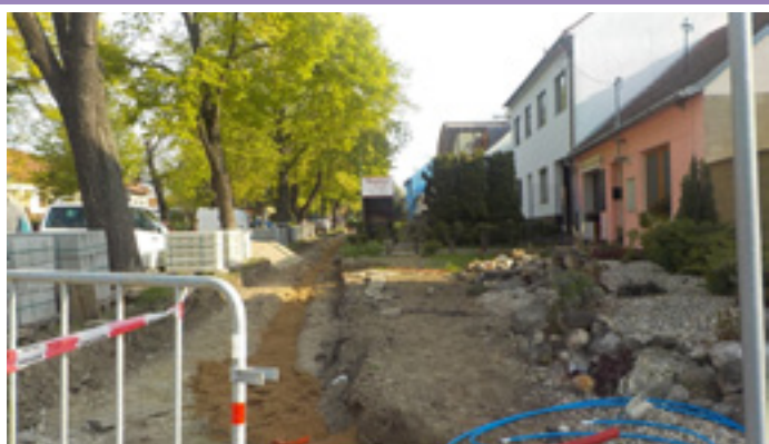
Zahájení opravy chodníku na ulici Hlavní
