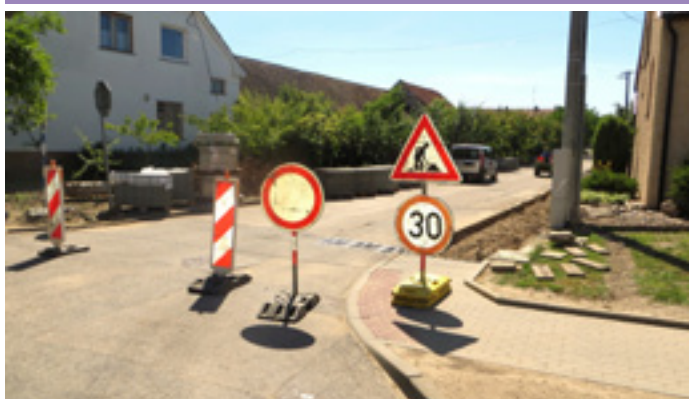
Dokončení opravy chodníku v Bálkově uličce
