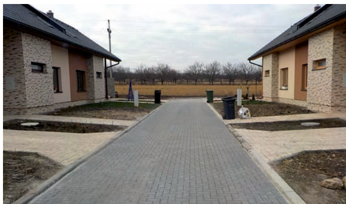
Nová vozovka ze zámkové dlažby na Padělkách
